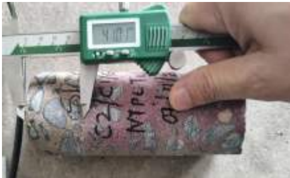
ताजा निकाले गए कंक्रीट कोर पर कार्बोनेशन की गहराई मापी जा रही है
