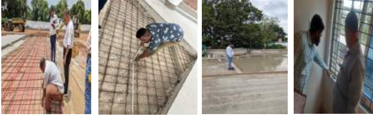
ओडिशा में प्रथम चरण के एएमए बस स्टैंड भवनों, ओएसआरटीसी का टीपीक्यूए निरीक्षण
