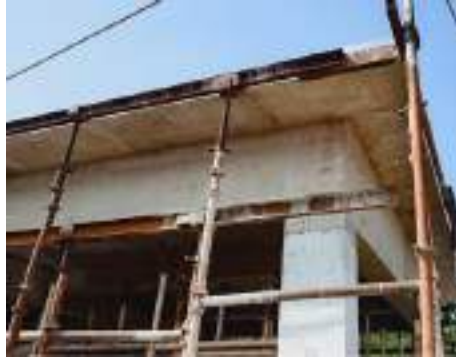
जियोपॉलिमर कंक्रीट से निर्मित एकल मंजिला संरचना की तैयार सतह
