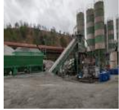
जियोपॉलिमर कंक्रीट मिश्रण के उत्पादन के लिए बैचिंग प्लांट की स्थापना
