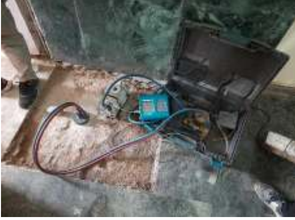
दिल्ली में एक भवन संरचना के स्लैब पर वायु पारगम्यता परीक्षण
