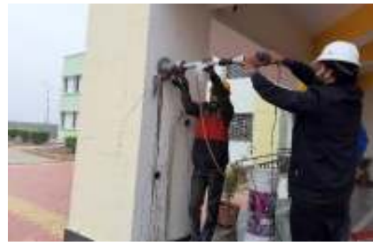
कंक्रीट कोर एक्सट्रैक्शन फॉर्म एनटीपीसी गाडरवारा में टाउनशिप बिल्डिंग का आरसीसी कॉलम
